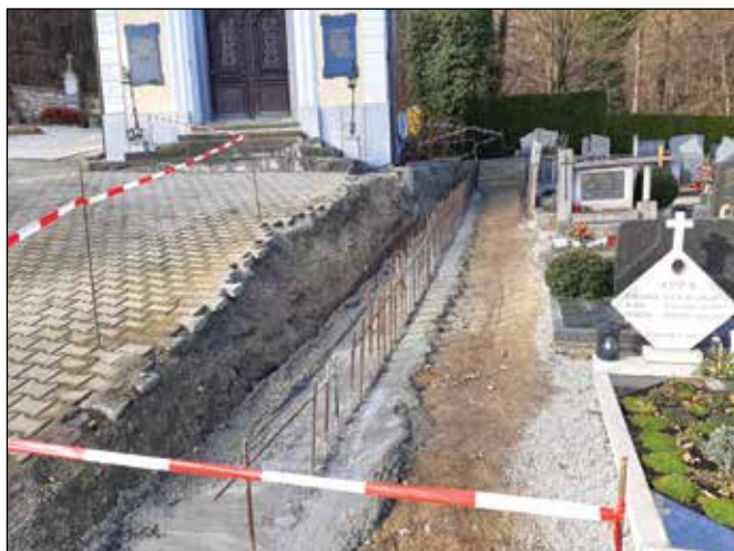
Sanacija opornega zidu na zgornjem delu pokopališča v Framu
