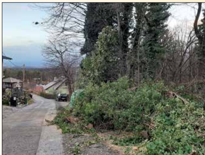
Odstranjevanje dreves in vejevja po februarjem vetrolomu; Morje
