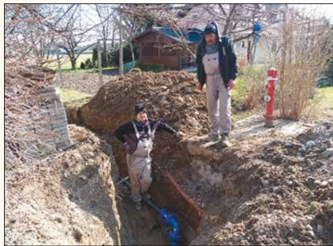
Prevezava transportnega vodovoda v Framu
